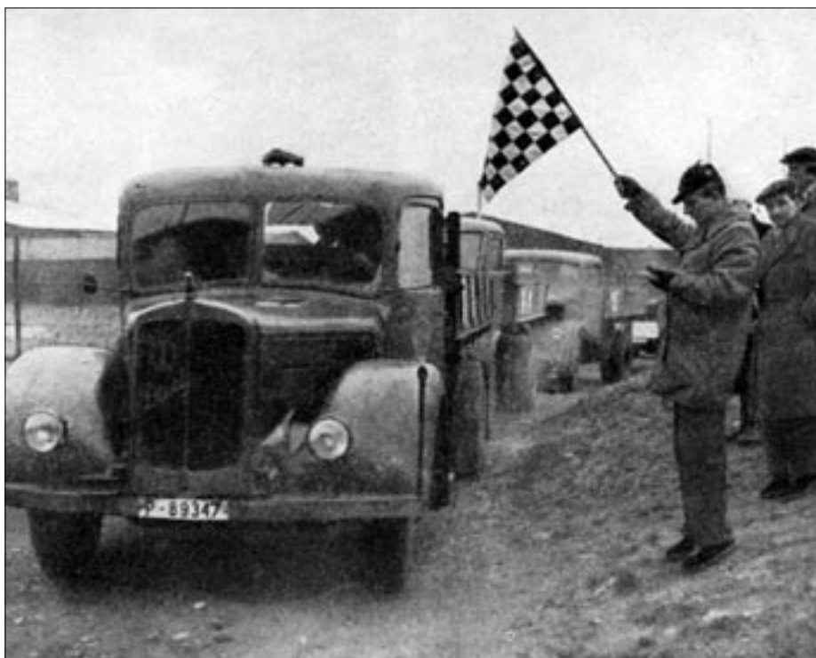
Start k budovatelské soutěži řidičů nákladních vozidel Pozemních staveb n. p., závod IV, podzim 1952.
