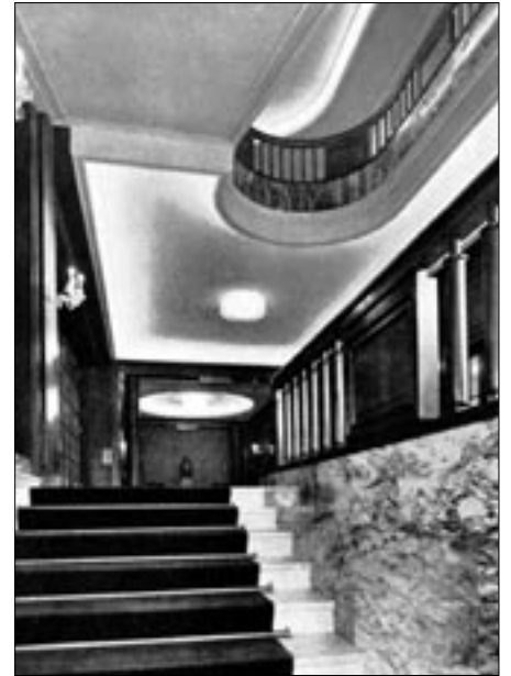
Janákova architektura byla velkorysá a důstojná. Zde schodiště do prvního patra.
